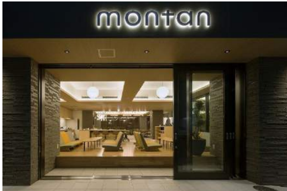
▲受賞したmontan HAKATA 外観ファサード
